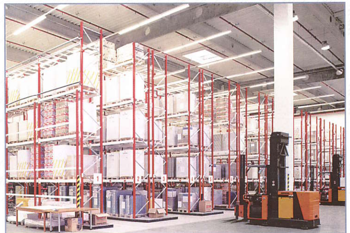
Склад с високостелажна конструкция за хартия върху специално изпълнение палети, обслужван от електрокар за тесни коридори
